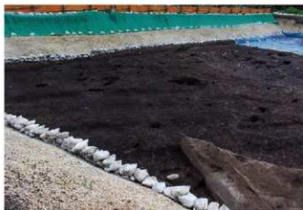
5 6・8号畠完掘状況(西より)
