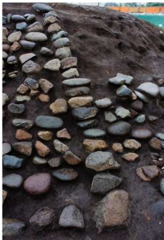
4 1号墳葺石配置区画別(南より)
