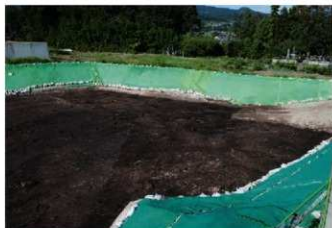
4 10区南部全景(南西より)
