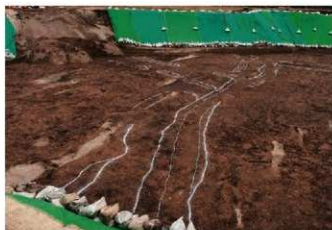
8 15号道完掘状況(東より)
