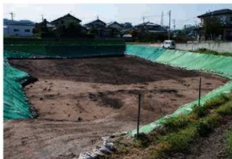
3 10区南部全景(南東より)
