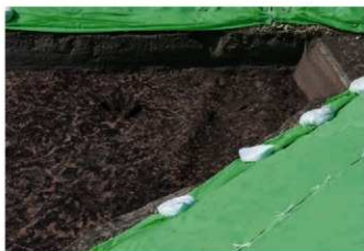
3 19号道完掘状況(東より)
