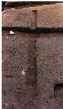
7 61号溝完掘状況(東より)
