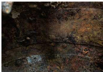
写真342 鉢内面の胴巻板と地板の釘留め状態
