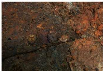
写真345 伏板と地板第1段に打たれた釘脚
