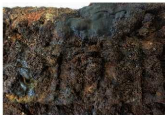
写真166 後胴竪上第1段中央部
