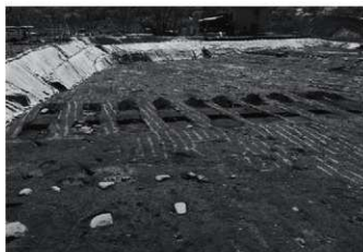
8. 復旧溝全景(西から)
