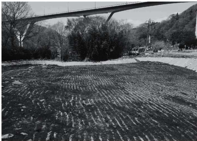
1. C区全景(東から)
