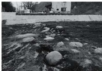
2. 1号道東部(西から)
