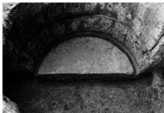
6 14号建物2号埋設桶断面(東から)
