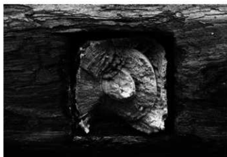
4 槽場男柱、底部近くの貫の様子
