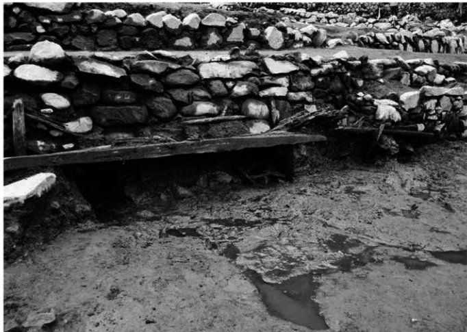
1 薪場北側、角材の上に薪(南東から)
