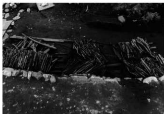
5 解体中の薪場南側、角材の上に薪(西から)
