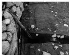
6 薪場南側杭 E-E' (南から)
