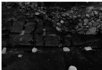
7 11号建物土壁解体状況(東から)
