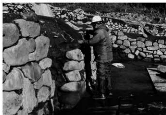
6 12号石垣解体状況(南東から)
