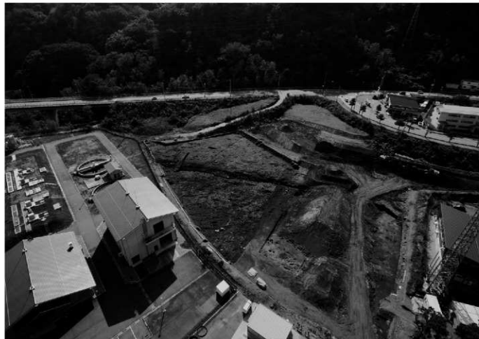
1 B区1面 調査区全景 北から
