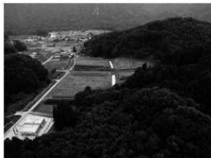
北方上空より調査地を望む
