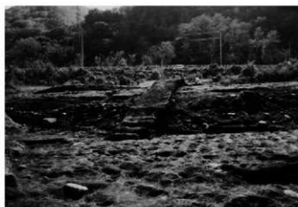
3 段差石垣状況(2号石垣) 北東から
