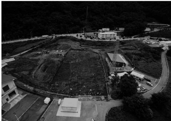
1 A区1面 調査区全景 北から
