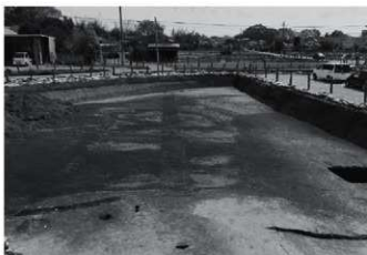
4. B4区南部旧流路(西から)
