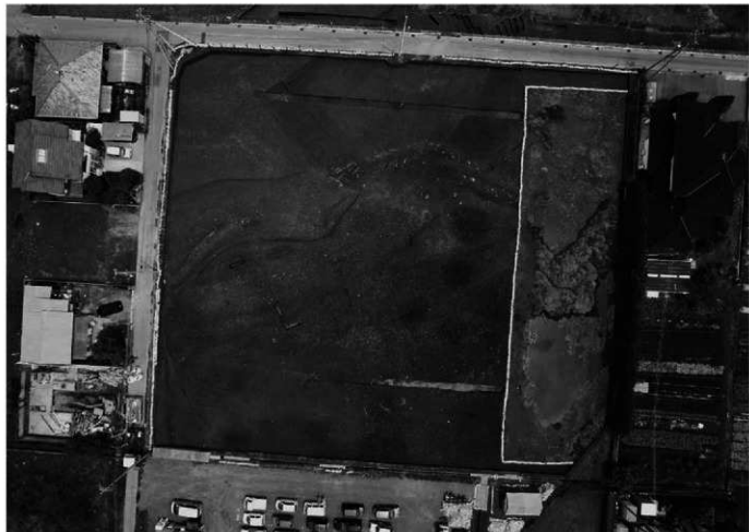
Ⅶ区1面全景 西上空より
