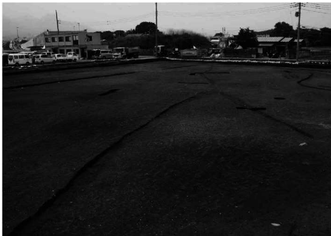
Ⅷ区2・3号溝全景 南より
