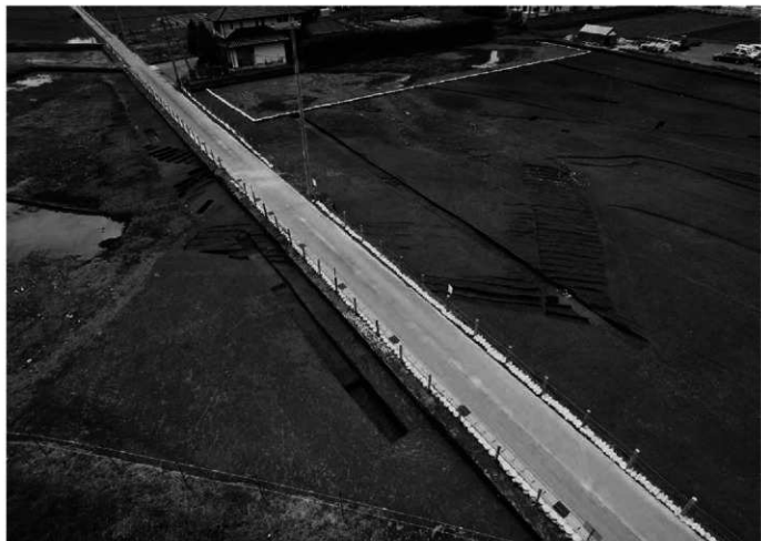
Ⅶ・Ⅷ区1面全景 北上空より
