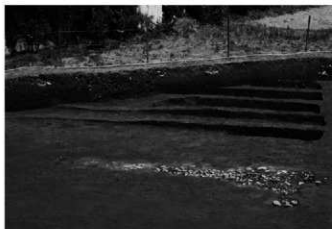
X区1号復旧痕全景 南西より
