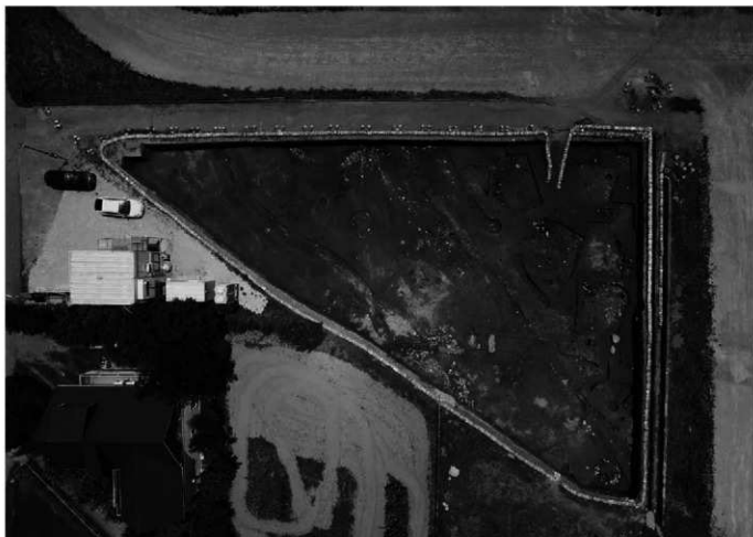
X区2面全景 北上空より
