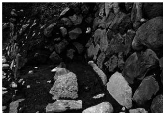
6. 北石垣張り出し部西部の鉄板(南東から)
