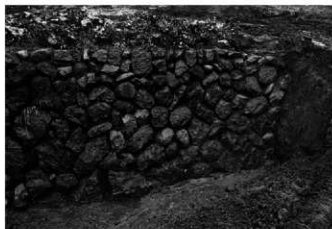
4. 北石垣東端部(南東から)
