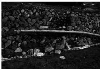
7. 北石垣中央の張り出し部東部(南東から)
