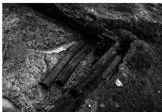
3. 西小屋下面木組み(南西から)
