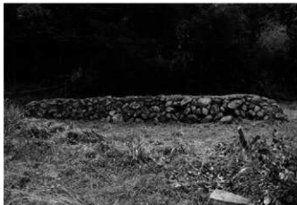
2. 礎石建物調査前の石垣(南東から)
