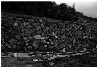
5. 北石垣中央の張り出し部(南東から)
