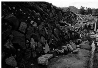
3. 北石垣西部から中央部(南西から)
