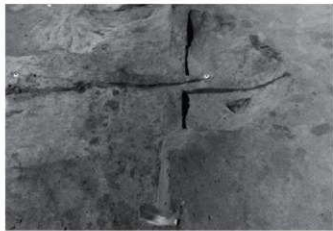
1. C区44号住居土層断面C-C' (南)
