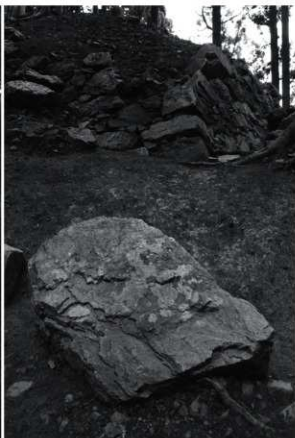
3 西槽台南東隅の転落した鏡石 (南から)
