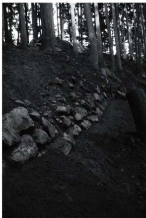
2 下段石垣 (西から)
