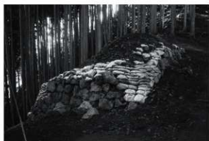
図6 西槽台養生状況1（北東から）
