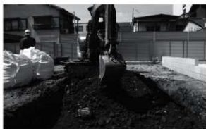
図3 重機掘削風景（北から）
