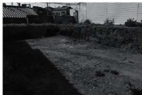
図2 調査前全景（南東から）
