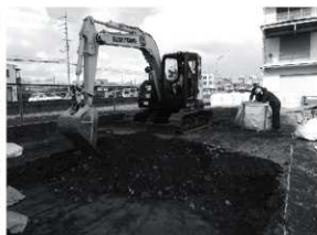
図3 重機掘削 (南東から)
