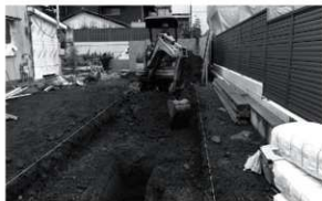
図2 重機掘削風景(南から)
