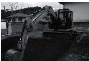
図3 1区重機掘削状況（北東から）
