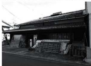
図2 被災前建物（南西から） 2)
