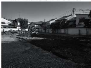
図5 埋め戻し風景（北西から）
