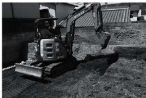
図3 2区重機掘削状況（北東から）
