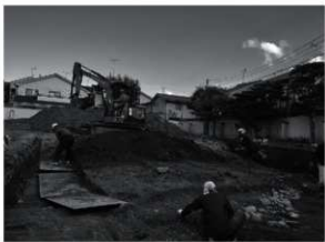
図2 重機掘削風景（西から）
