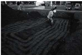
図5 1区埋め戻し状況（南西から）
