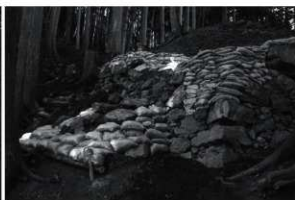
図7 西槽台養生状況2（南東から）
