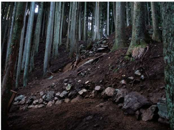
2 下段石垣と西櫓台（東から）
