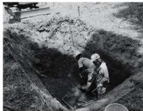
図5 人力掘削作業状況(南東から)
