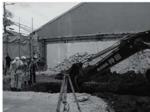
図4 重機掘削作業状況(東から)
