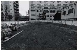
図6 埋め戻し後 (西から)
