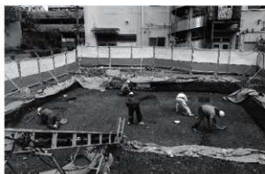
図4 1区作業風景 (西から)
