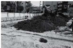
図5 3区埋め戻し状況 (南西から)
