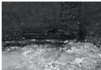
5 1区5号住居床上・床下土層断面(西より)
