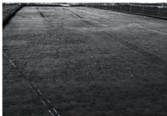
1 4区6号復旧畑(東より)
