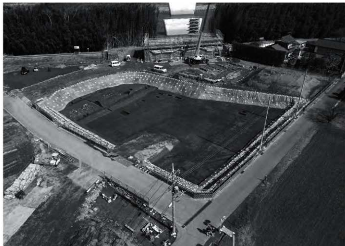
2 1-1区中・西南部3面(南西より)
