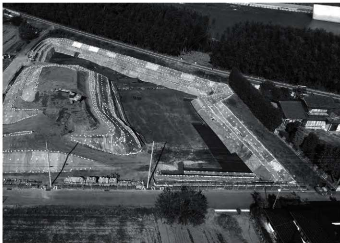
1 1-1区東部4面全景(南より)
