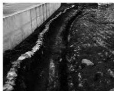
9. 16号道・20号溝(東から)
