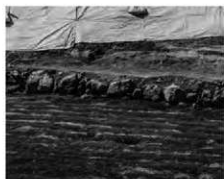
12. 19号道・6号石垣(南から)
