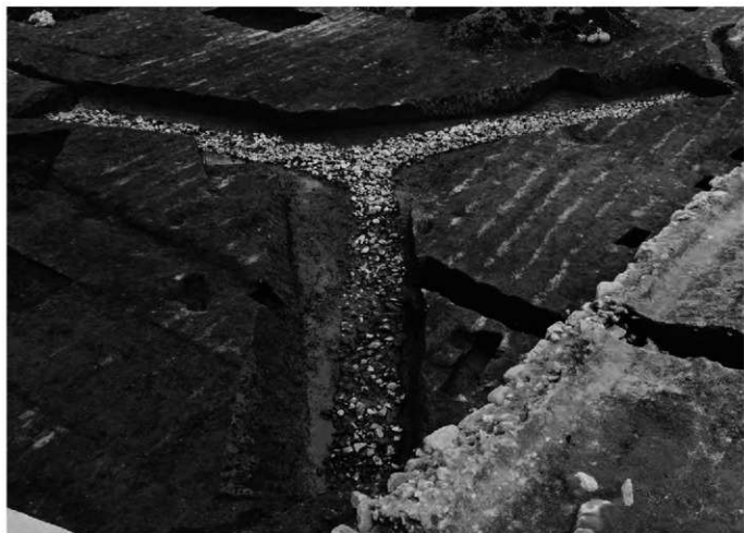
3. 1号暗渠全景(北東から)
