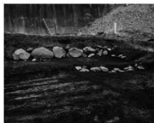
10. 18号道(南西から)
