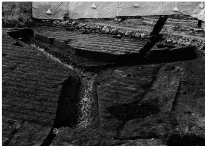
2. 1号暗渠掘り方(南から)
