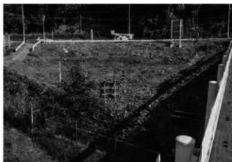
1. 1号建物調査前風景(南から)
