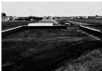
2. 2区As-B下水田(西から)
