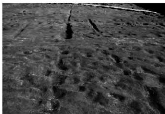
3. 5区1号復旧溝群土層断面(西から)
