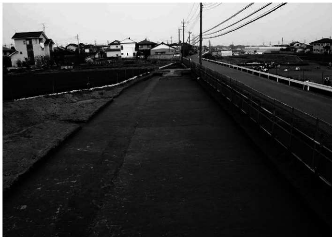
1. 5区第1面西側南半部全景(西から)
