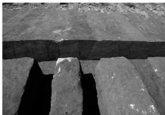
1. 4区1号復旧溝群土層断面(南から)
