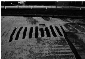
2. 3区1号復旧溝群全景(南から)
