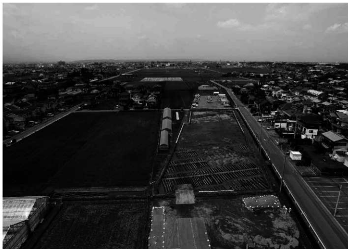
1. 3区第1面全景(東上空から)
