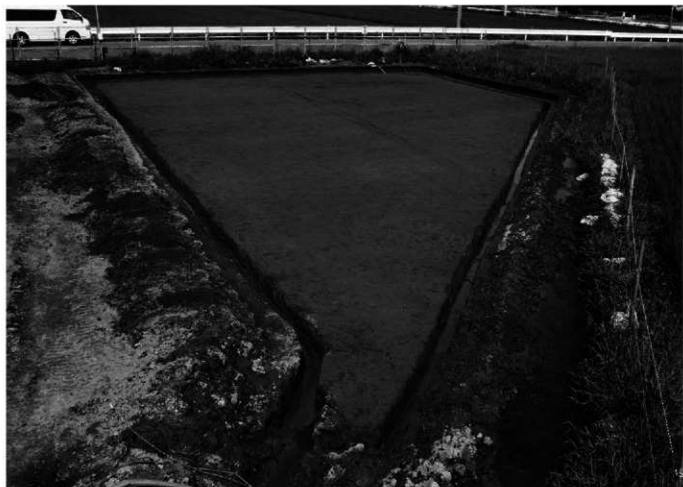
4. 5区第1面西側北半部全景(東から)
