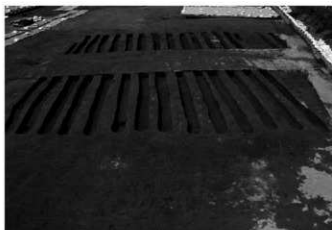
7. 4区4号復旧溝群全景(東から)
