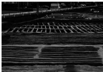
2. 3区4・5・7～9号復旧溝群全景(西から)
