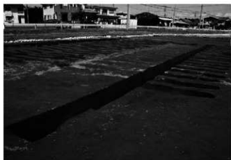
8. 4区1号復旧溝群土層断面(南西から)
