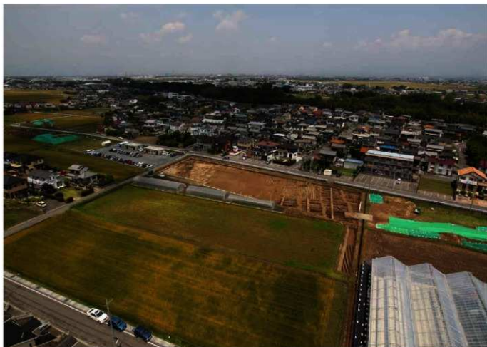
1. 3区第1面全景(南上空から)
