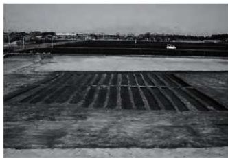
5 3区3号復旧溝群全景(南より)
