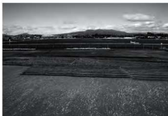
4 3区7号復旧溝群全景(南より)
