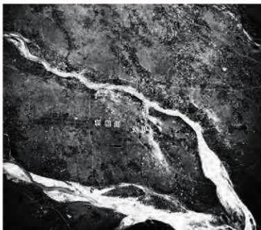
写真1 キャスリーン台風被災状況 (1947年10月30日米軍撮影、国土地理院「高崎」使用)
