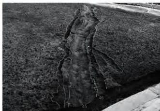
5 1区43～51号溝(北西より)
