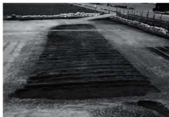
4 3区2号復旧溝群全景(北より)
