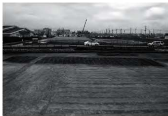
3 3区2号復旧溝群全景(東より)
