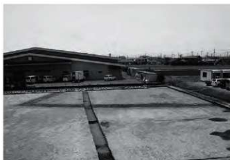
7 2区13・14・15号溝全景(北より)
