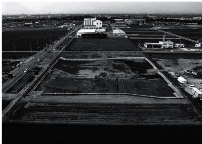
1 1区2面航空写真(南より)
