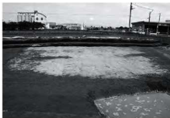
5 1区3号復旧溝群As-A堆積状況 (南より)
