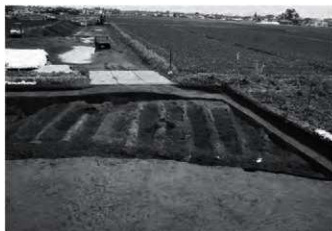
2 3区10号復旧満群全景(西より)
