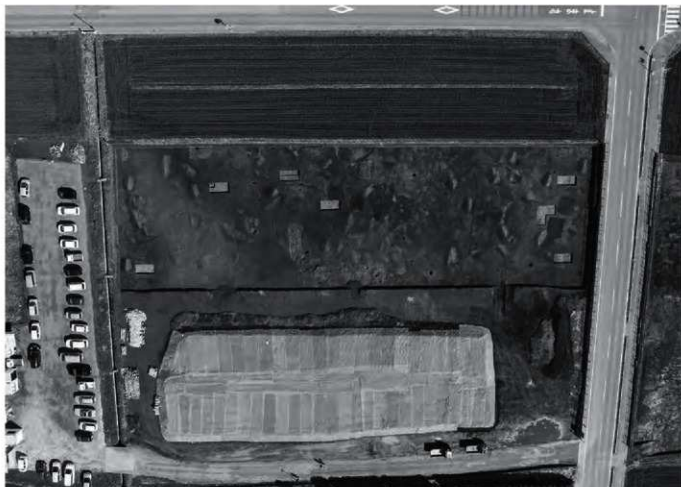
2 2区北半部4面航空写真(上側が北)
