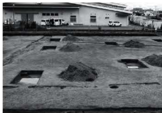
8 2区中南部旧石器確認調査掘削状況(北より)
