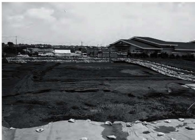
2 1区2面南部全景(西より)
