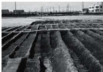
5 3区7号復旧溝群掘削状況(東より)
