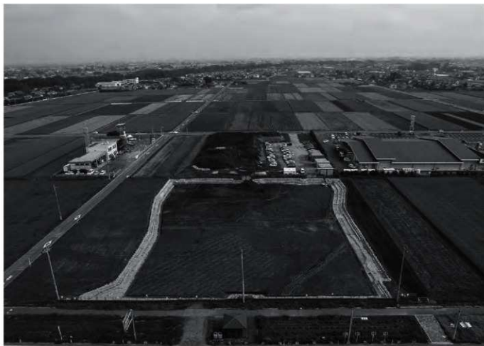
1 1区4面航空写真(西より)
