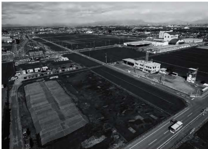
1 2区北半部4面航空写真(南東より)
