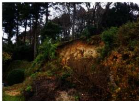
調査地全景 (斜面下から)
