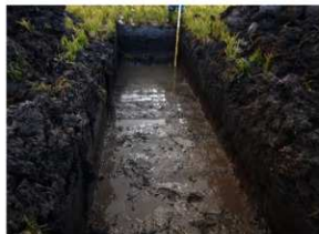
5号トレンチ土層状況 (東→)
