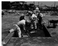
9. 調査風景(西から)
