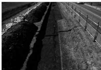
4 2区水田面中央部確認面(東から)
