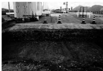
3 1区西端部トレンチ(南から)
