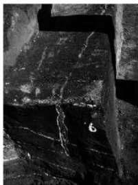
第193図 地割れのような薄い楔状の地変痕跡
