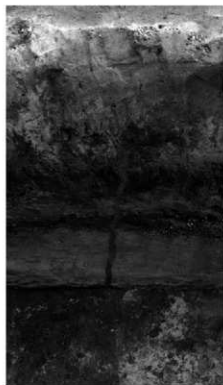
2. 10号トレンチ噴砂確認状況(北から)
