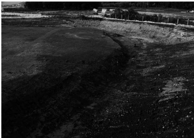
7 5区1面3河道全景 南から
