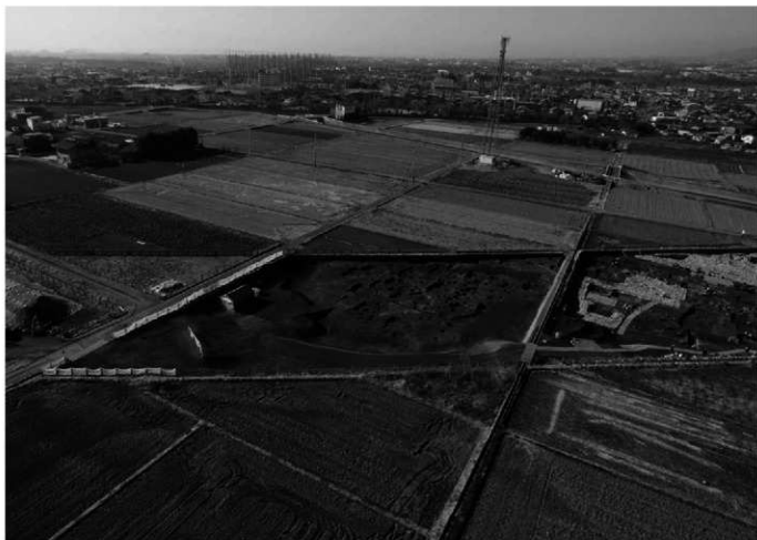
1 5区2面空撮 北上空から
