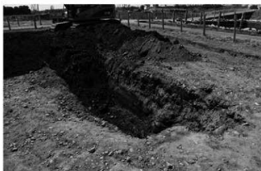
2 3区1面復旧溝確認トレンチ 北から
