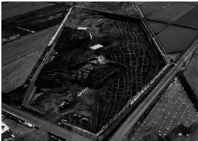
2 4区3面空撮(南側) 北西から
