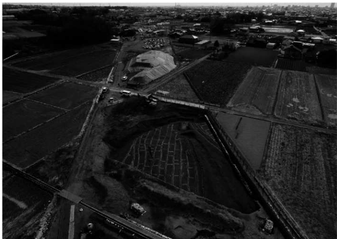
1 5区3面水田空撮 西上空から
