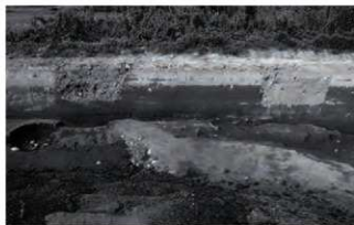
▲3区東壁の土層と復旧溝 西から
