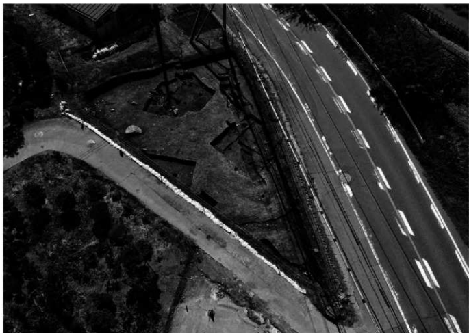
1区全景 北西上空より
