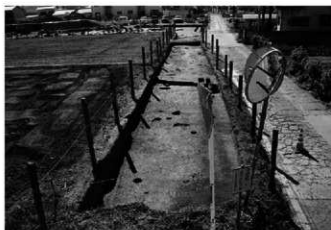
④ 東3区北側拡張区遠景(北より)
