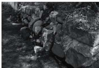
5 尋常小学校跡地 南辺石垣 残存状況 南から
