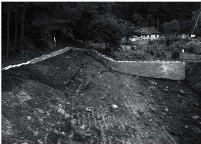
1 平成23年度調査 33区 6号畑-1 全景 西から
