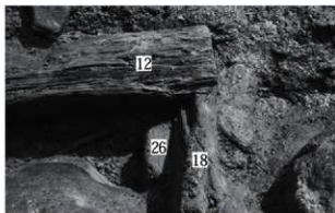
1号建物1号床 根太・大引・東の接合状況 南から
