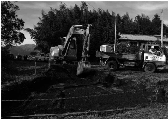
2. 重機による表土層の掘削・搬出状況(東より)
