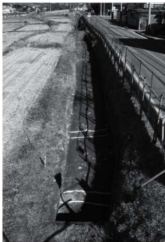
2. 調査区(南半)全景(南より)
