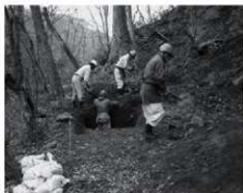
14 3号トレンチ調査状況(南東から)
