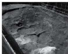
10 北側全景(北から)
