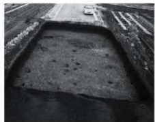
1 53・63区町道2面東部全景(西から)
