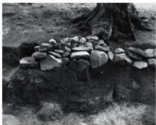
2 5号石垣(南から)
