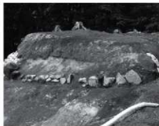
2 1号石垣全景(北東から)
