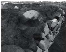
5 2号石垣解体(西から)
