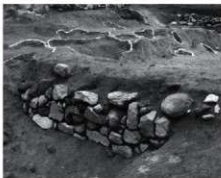
2 2号石垣と土橋全景(東から)
