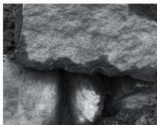
8 2号石垣欠跡の残る石(南から)
