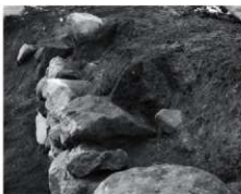
6 2号石垣解体(東から)
