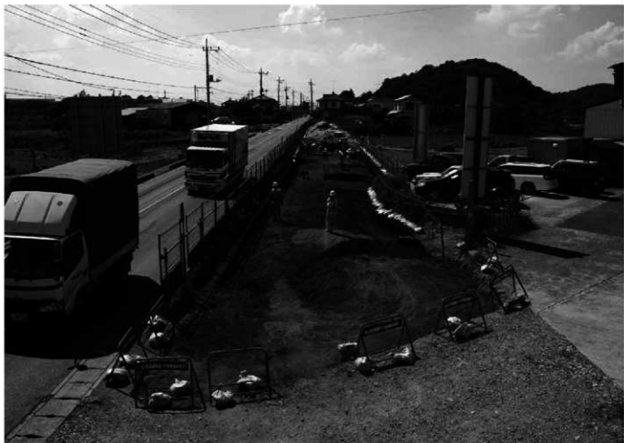
2 寺中道跡1区西側全景(東から)
