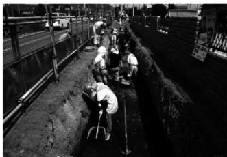
8 調査状況(南から)
