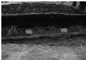
5. 2区16号・17号竪穴住居 掘方 土層断面(東から)
