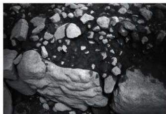
3 奥壁と裏込め(南西から)
