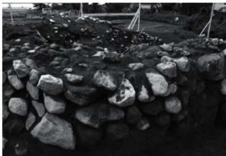
2 裏込め北外側(北から)
