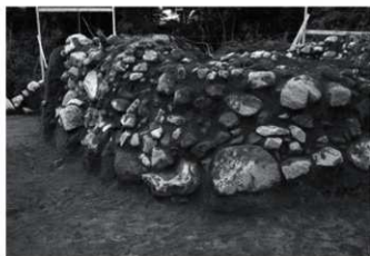
3 裏込め東外側(東から)
