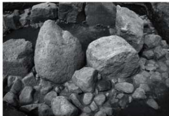
3 東壁26・27裏込め状態(東から)
