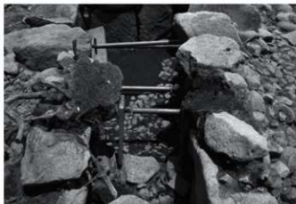
6 天井石下(南から)
