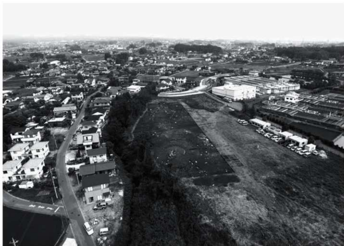
2 上空から見た道跡(南から)
