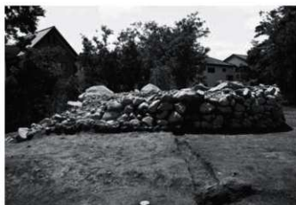
3 裏込め東側面(東から)
