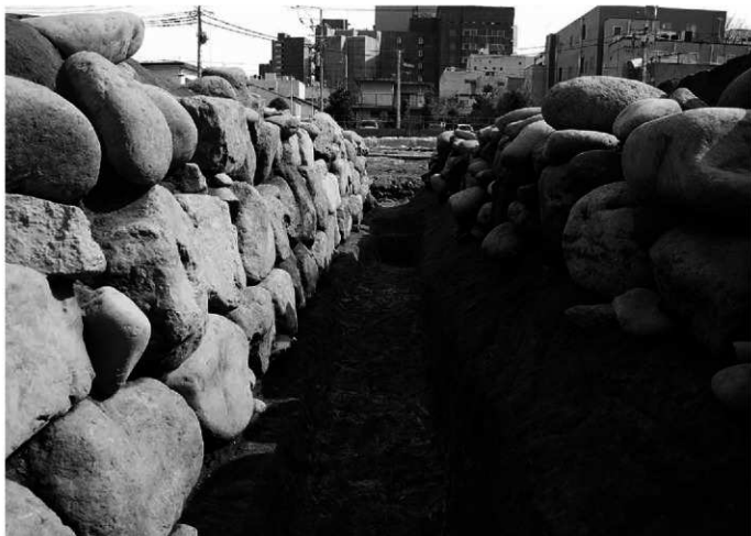
3 6号溝石組み 西→ 南側（写真右手）と比べ、北側の石組みは丁寧に積まれている
