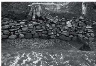
7 7-1号石垣(南より)
