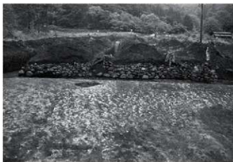
6 7-1号石垣(南より)
