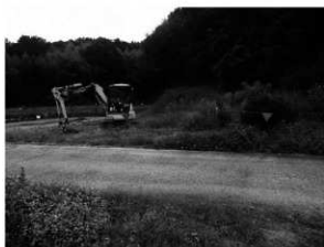
写真7 1 トレンチ周辺の状況
