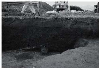
C区6住居土層断面 W-X 北半部 東から
