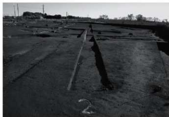
B区地形確認2トレンチ 西から
