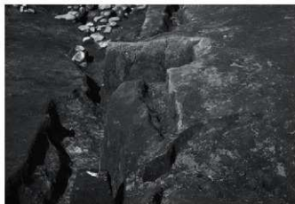
B区3井戸水源部地割れ2 南から
