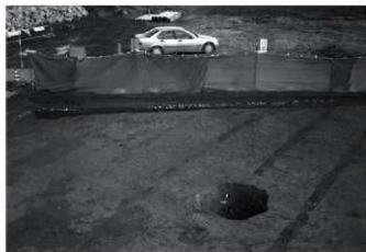
A区1 道路、1 土坑 西から
