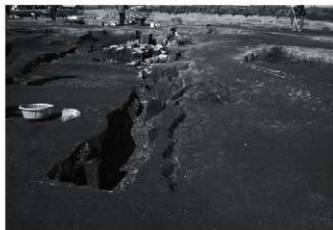
B区3井戸水源部地割れ1 南から
