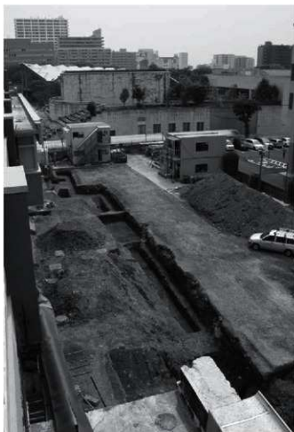
3区全景 西上空から
