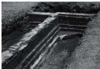
2区-②煉瓦とコンクリートの基礎2 西から
