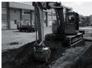
1区の表土掘削
