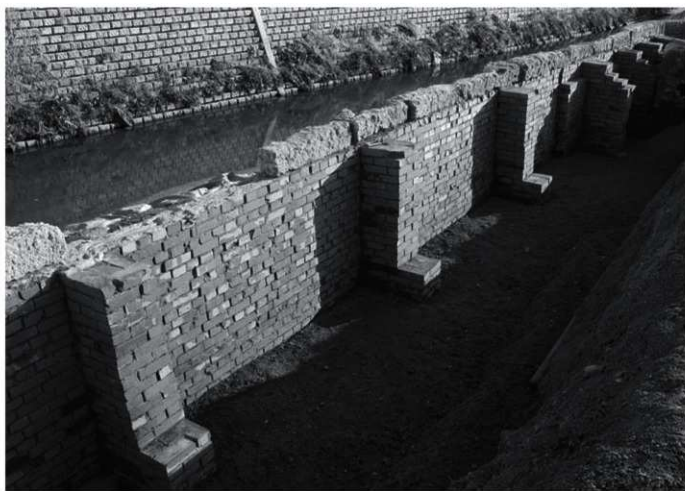
煉瓦積護岸背面（南西より）
