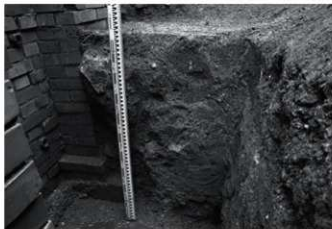
支え壁14裏込土層断面(西より)
