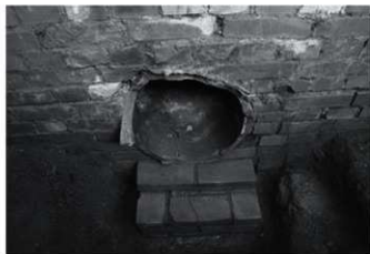
1号埋設管 護岸連結部(南より)
