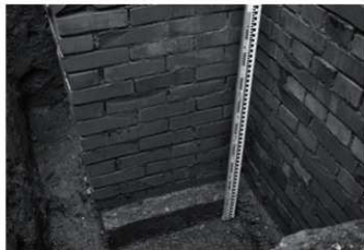
支え壁14基礎コンクリート(南東より)
