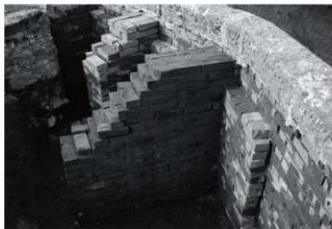
背面支え壁21屈曲付近側面(東より)
