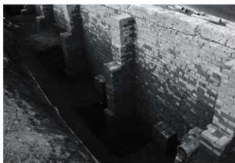
支え壁14背面基底部(南東より)
