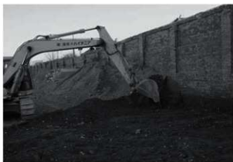
機械掘削状況(北より)
