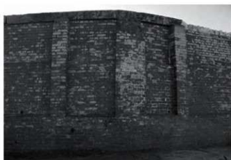
煉瓦積護岸屈曲部表面（北より）
