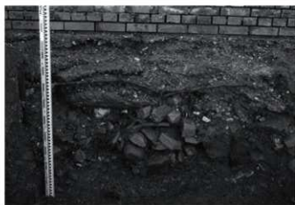
基礎土層断面（北より）
