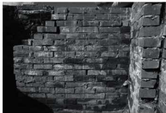
支え壁21背面側側面(東より)
