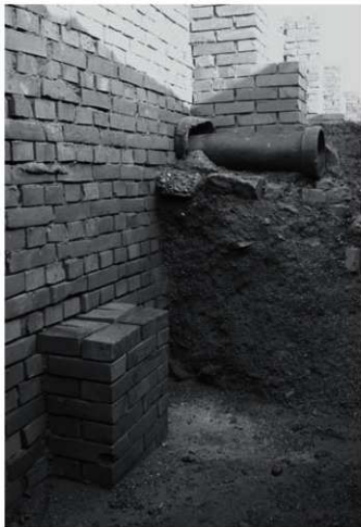
背面支え壁b・支え壁15と2号埋設管(西より)
