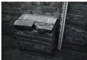
背面支え壁a(北より)
