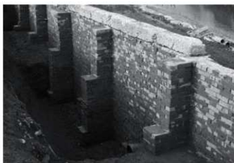
支え壁13・14・15背面(南東より)
