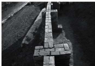
支え壁16・17付近煉瓦積頂部(西より)
