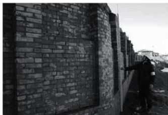
煉瓦積護岸屈曲部表面全景（東より）
