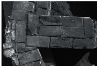
支え壁21上段第1列上面(西より)
