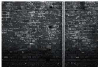
支え壁13・14間表面水抜き穴(北より)
