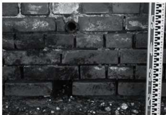
水抜き穴表面下位(北より)
