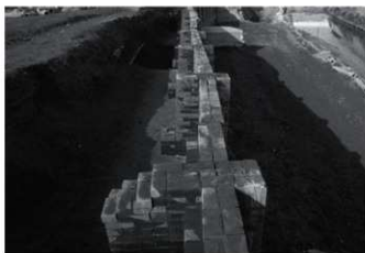
石列除去後の煉瓦積護岸上面(東より)
