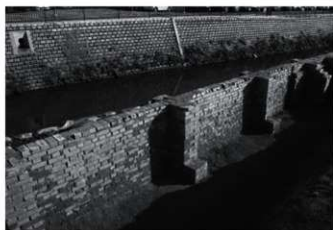
支え壁16・17背面(南西より)
