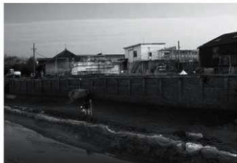
煉瓦積護岸表面全景（北西より）
