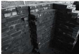
背面支え壁18付近変換部(南西より)
