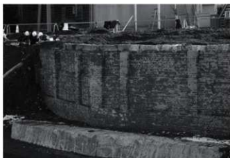
煉瓦積護岸屈曲部表面（北西より）
