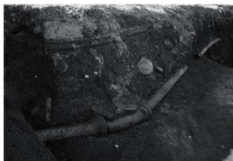
背面消火栓管全景(北東より)
