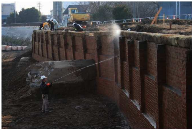
煉瓦積護岸表面の洗浄（西より）
