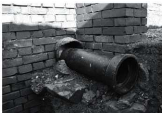
2号埋設管(背面、南西より)
