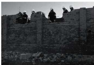
煉瓦部分解体作業(北より)
