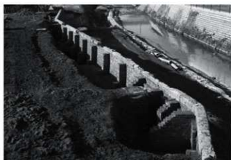
煉瓦積護岸背面(南東より)
