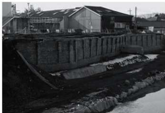
煉瓦積護岸表面全景（南東より）
