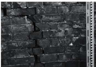
屈曲部表面煉瓦積(北より)
