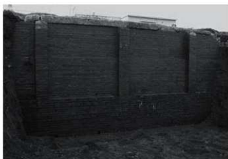
煉瓦積護岸東部表面（北より）
