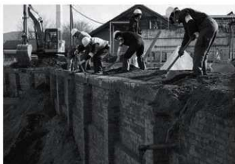
護岸上面表出作業(北西より)
