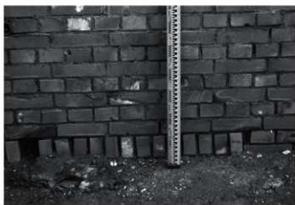
煉瓦積護岸東部表面下位（北より）
