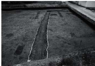
1 2号溝全景(南西から)
