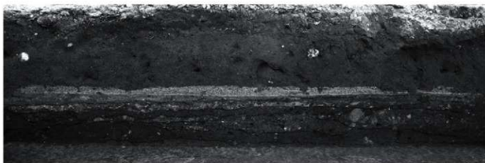
② 1号道路南側断面(北西から)
