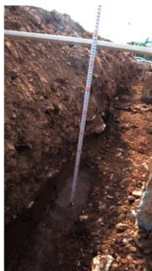
写真2 立会箇所の堆積状況
