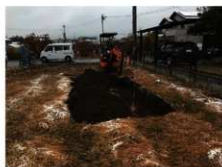
調査風景(東から)
