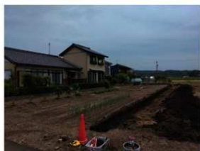
掘削風景（西から）
