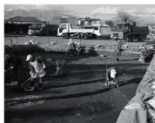
15. 3区作業風景(南から)
