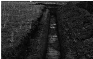
写真 77 12 トレンチ 南から
