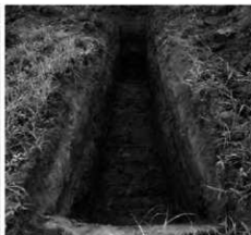
写真 40 56 トレンチ 東から
