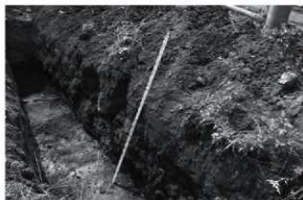
写真22 36トレンチ 西から
