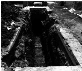
写真46 9トレンチ 南から
