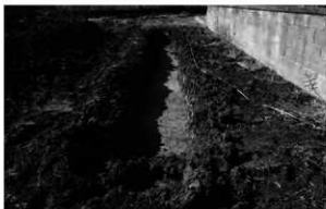
写真 54 10 トレンチ 東から
