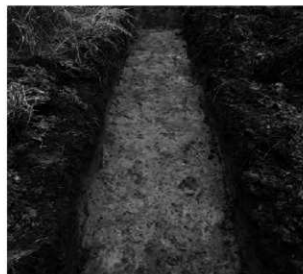
写真 35 48 トレンチ 南から
