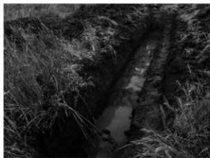
写真 37 52 トレンチ 南西から
