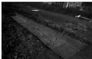
写真 66 31 トレンチ 南東から
