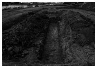
写真 94 9 トレンチ 南から
