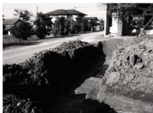
写真70 4 トレンチ 南東から
