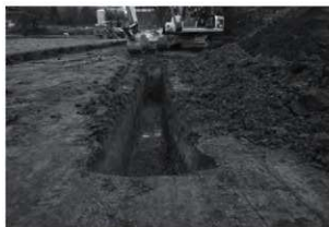
写真 84 1 トレンチ 南東から
