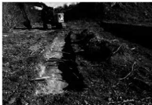
写真 21 34 トレンチ 西から
