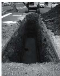
写真 43 4 トレンチ 南から
