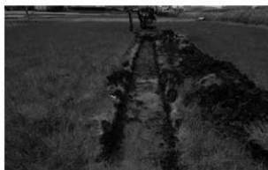
写真 58 13 トレンチ全景 北から
