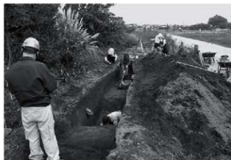
5 4号溝の調査風景・平成24年度(西から)
