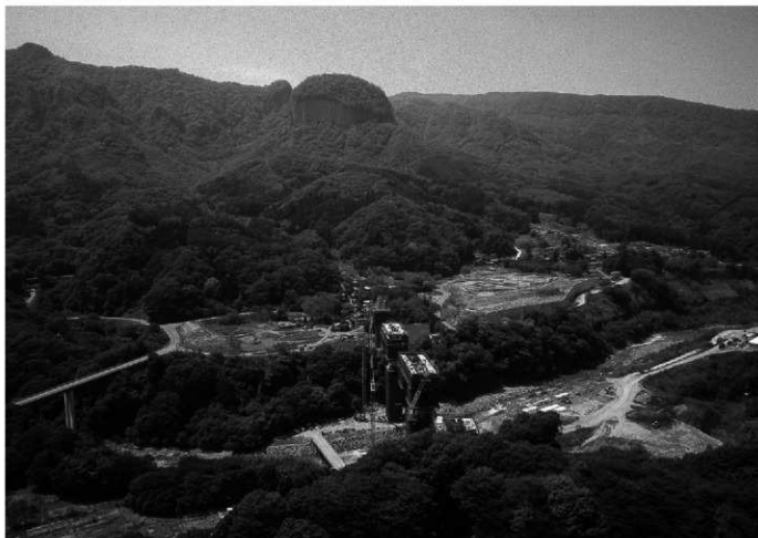
道跡遠景(北東から) 中央を東西に流れる吾妻川に橋を架けているところで、橋の向こう右手の平地が本道跡。上方の屹立する岩場がランドマークの丸岩。平成20年5月撮影。
