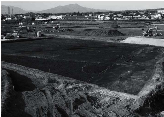
2 A区As-B下水田全景(南東から)
