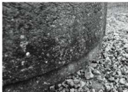
5 井戸枠側面の下部 端部を幅10cm削り込む
