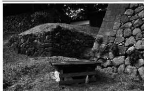
6 井戸跡の現況 奥は水ノ手門
