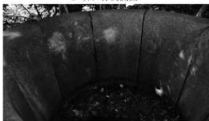
6 井戸枠内面 板石の形状は下部が狭い台形を呈する
