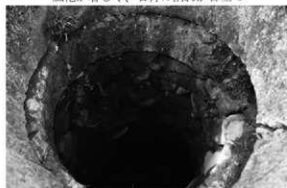
8 井戸跡内部 上2段は割り貫き材、下部は石組
