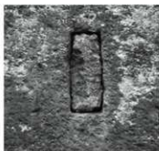
9 側面①の上部枘穴 9×4cmを測り、可塑性の素材 で埋められている
