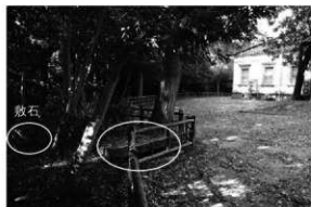
2 井戸跡の現況 後ろの建物は、旧歩兵第六旅団司令部庁舎
