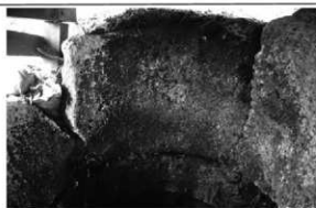
7 井戸枠(上段)内面 風化が著しく、石材の割れが目立つ
