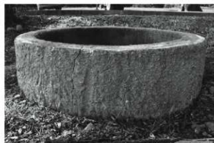
6 井戸側側面 ヒビ割れが 3 箇所程度、確認できる
