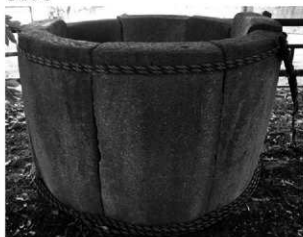
4 井戸枠側面 現況は板石が互いにずれており、全体形は歪む
