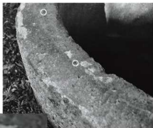
2 井戸側上面 (部分) 近代以降、石製井戸側の上にコンクリート製枠が設置される (現在撤去) コンクリート製枠を固定するための角釘及びその痕跡を約 10 箇所、その外部に枠当り痕を確認
